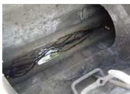
Les bandes sont placées sur le radier de la canalisation de manière à flotter sur 1 mètre dans les eaux usées.
