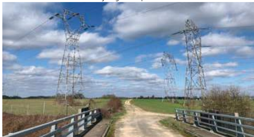
Traversée aérienne de l'A5 vers Blandy
