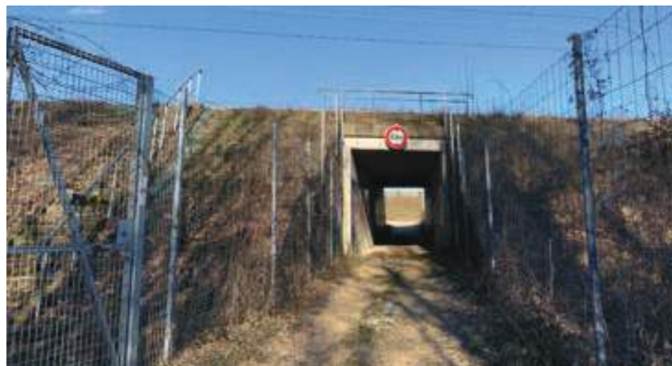
Passage sous le talus de la LGV
