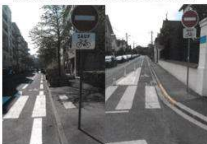
rue Brasserie Gruber rue Jeanne d'Arc
