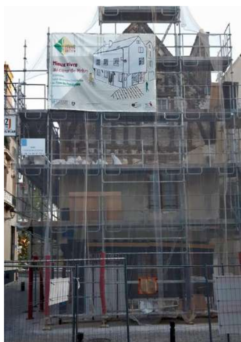
Début des travaux du 01 rue du Presbytère – mai 2022
