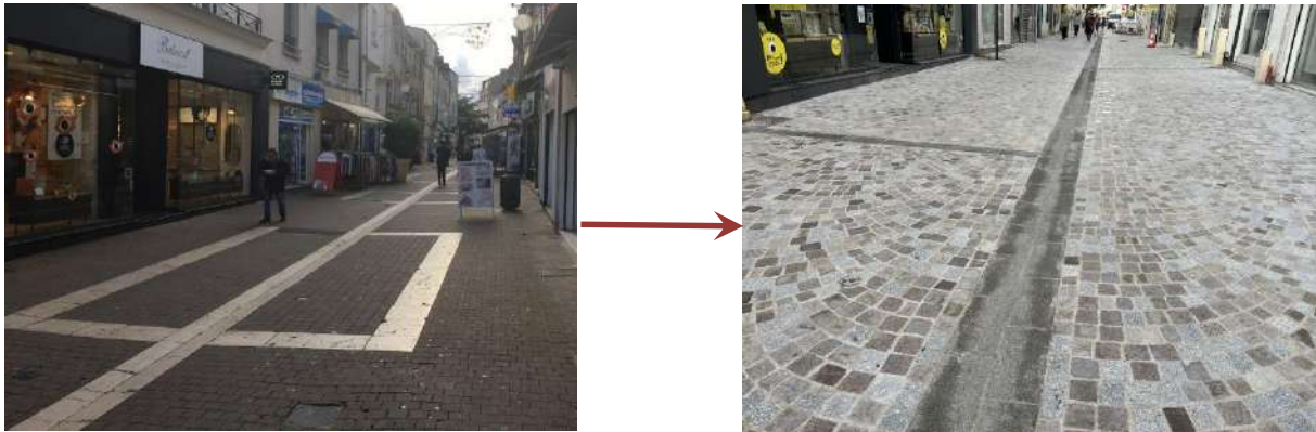
Travaux de revêtement avec pose des pavés en queue de paon (avant/après)
