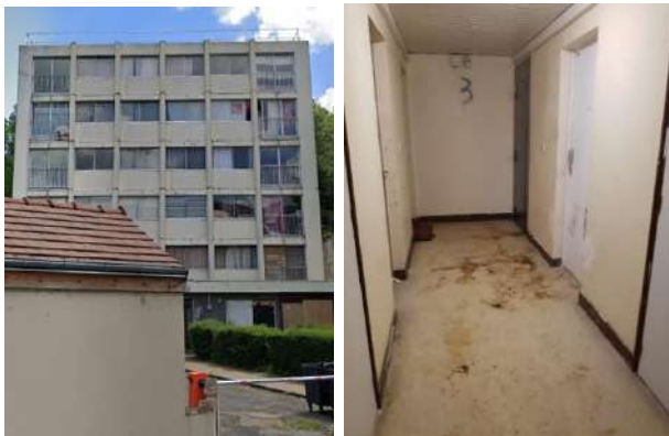
15 rue Gaillardon – état interne et externe
