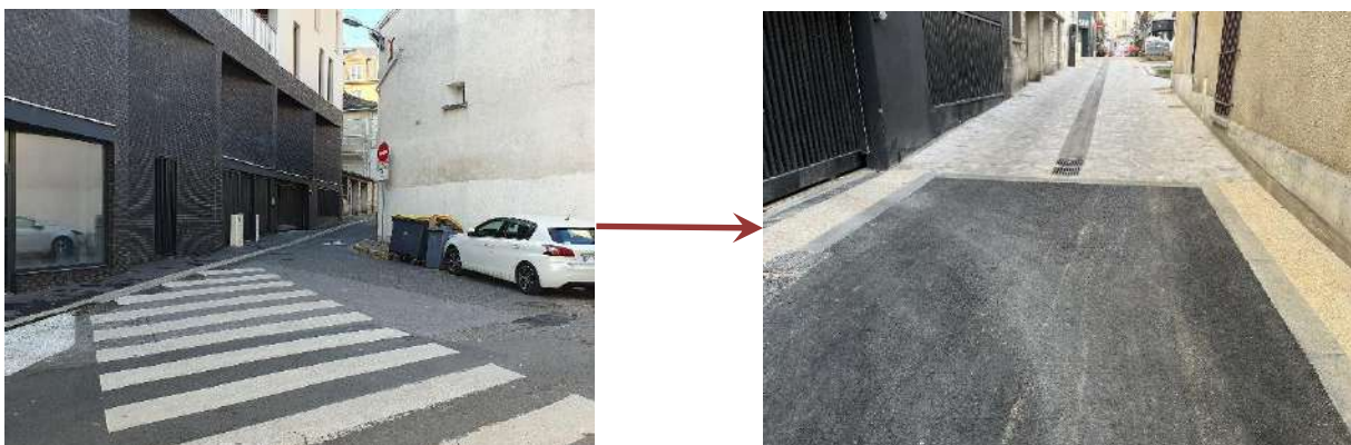
Travaux de revêtement sur trottoirs et chaussée, respectivement en béton désactivé et en enrobé (avant/après)
