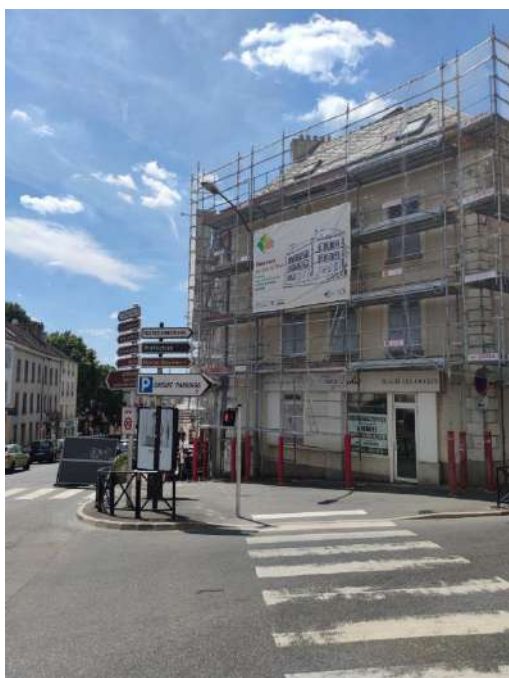
Début des travaux du 31 rue du Général de Gaulle – avril 2022
