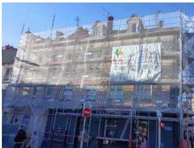
Début des travaux du 50 rue René Pouteau – décembre 2022
